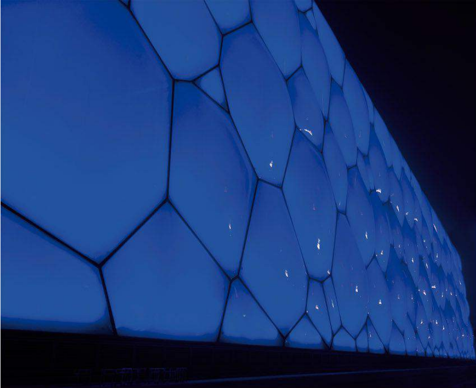
migawka architektoniczna z Pekinu, pływalnia olimpijska "Kostka Wody" architectural snapshot from Beijing, Water Cube - National Aquatics Center
